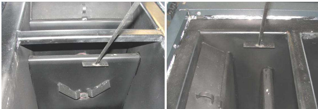
Фигура 6.1. Почистване на пепелта от стените на котела.
