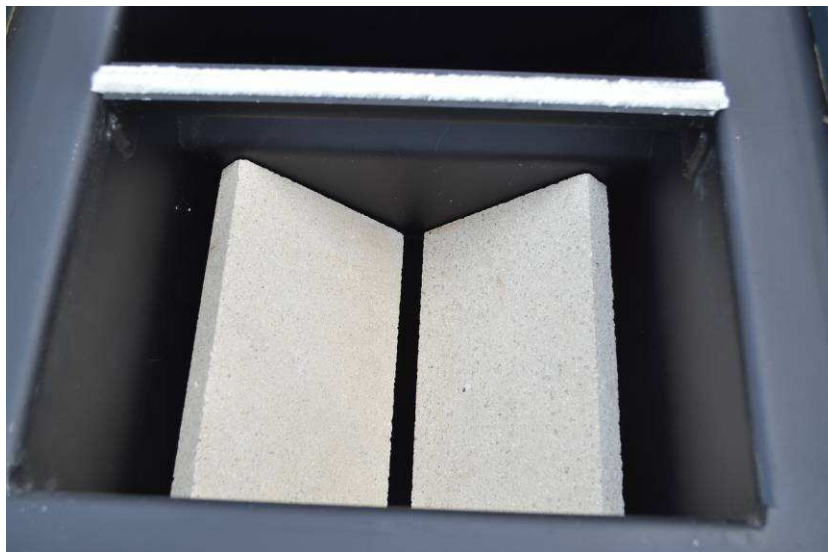
Фигура 5.4. Монтаж на шамотните елементи в пещната камера на котела.
